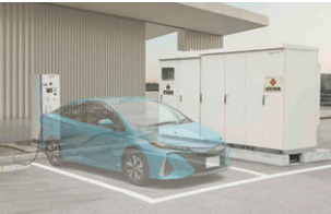
非常用電源「V2Xシステム」
