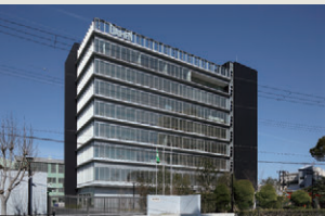
●本社・十三事業所 電力機器の製造・販売、 半導体機器の製造・販売
