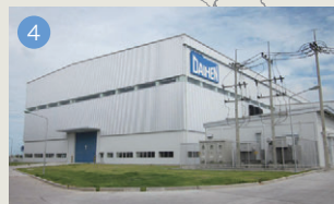
DAIHEN ELECTRIC Co., Ltd. (タイ) 大形変圧器等の製造・販売
