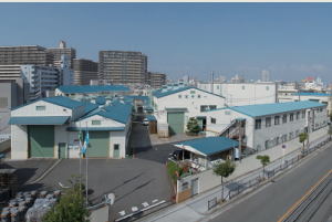
●兼平工場 柱上変圧器の修理
