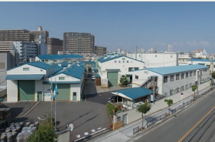
●兼平工場 柱上変圧器の修理
