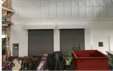
室外から見た断熱壁
