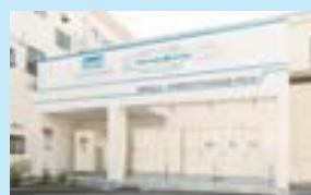
①：ダイヘン本社実証設備（太陽光+蓄電池システム）
