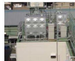
給湯用大規模エコキュートの導入(十三事業所)
