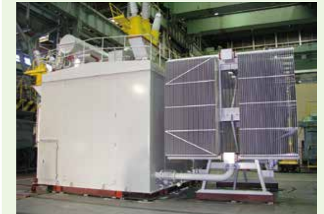
■三相77kV 60/30MVA 可変容量分路リアクトル
