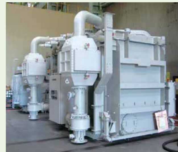
■三相77kV 45MVA ガス絶縁変圧器
