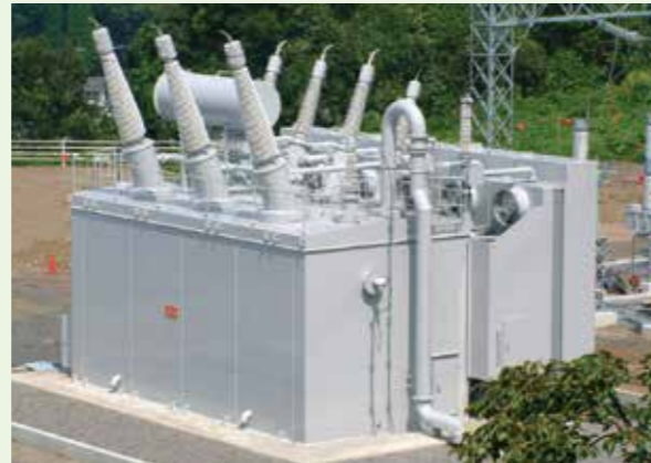
■三相275kV 350MVA 分解輸送変圧器
