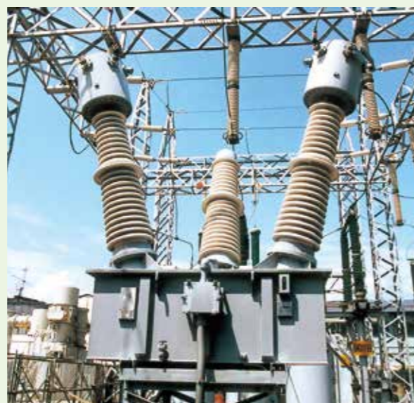
110kV VCTの例
