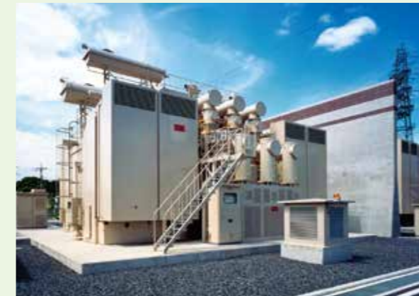
■三相275kV 300MVA 組立鉄板防音壁形極低騒音変圧器
