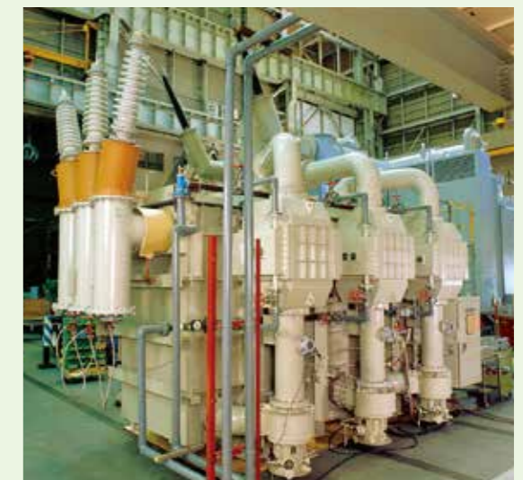
■三相77kV 30MVA ガス絶縁変圧器
