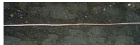
掘削溝に埋設地線を布設する
