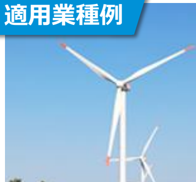
風力発電設備
