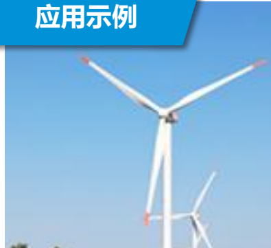
风力发电设备
