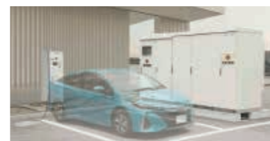
非常用電源システム[V2Xシステム]
