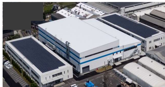
産業用油入変圧器 新工場
