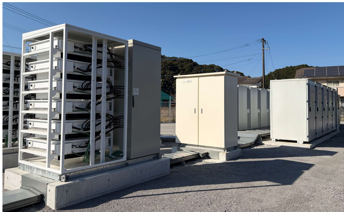
系統用蓄電池システム 1,988kW (8,146kWh) (NC唐津市相知町蓄電所)
