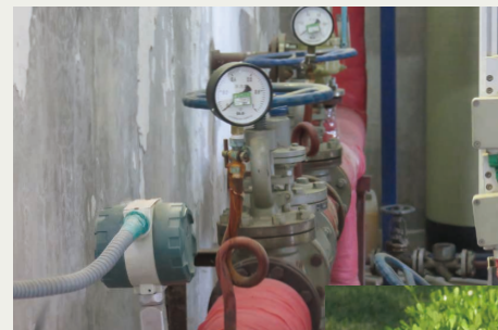
蒸気流量調整器
