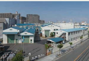
●兼平工場 柱上変圧器の修理
