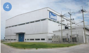
DAIHEN ELECTRIC CO., LTD. (台湾) 大形変圧器等の製造・販売
