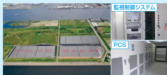
図2. 堺太陽光発電所に納入されたPCSおよび監視制御システム
