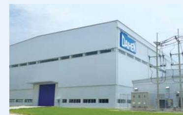
超高压変圧器工場
