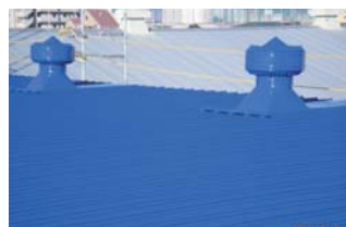
工場の屋根遮熱塗装
