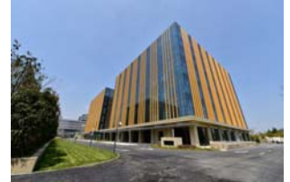
OTC上海新拠点が入るビル 事務所6F、テクニカルセンター1F
