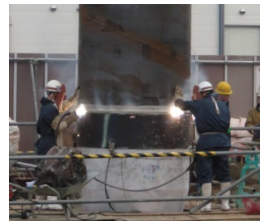
鋼管杭の溶接施工事例
